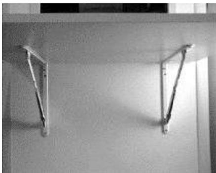
Sostenuto da due mensole ripiegabili è facilmente apribile. E' sufficiente sollevarlo fino a fare estendere il meccanismo di sostegno a fine corsa.
